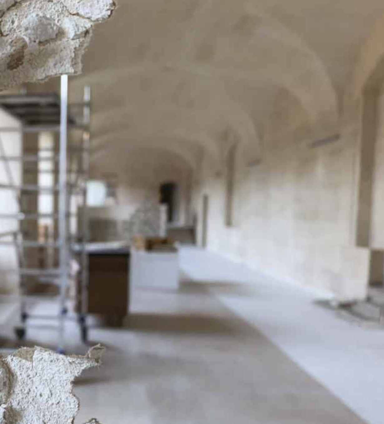
Début des travaux de la nouvelle bibliothèque juin 2021
